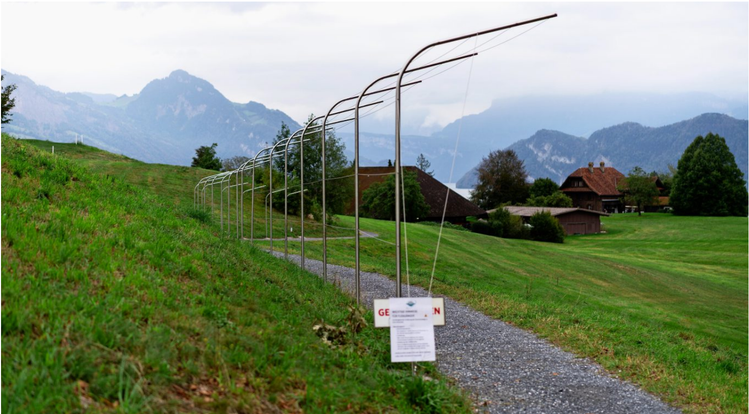
Der Panoramaweg erhält in diesem Bereich des Golfplatzes ein Schutznetz.
